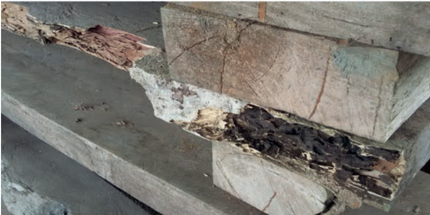
Figura 2. Peças de violeta atacadas por cupins.
