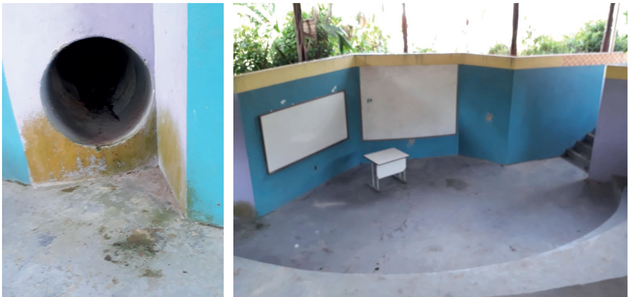
Figura 4. Ar-condicionado natural e auditório subterrâneo visto de dentro.
