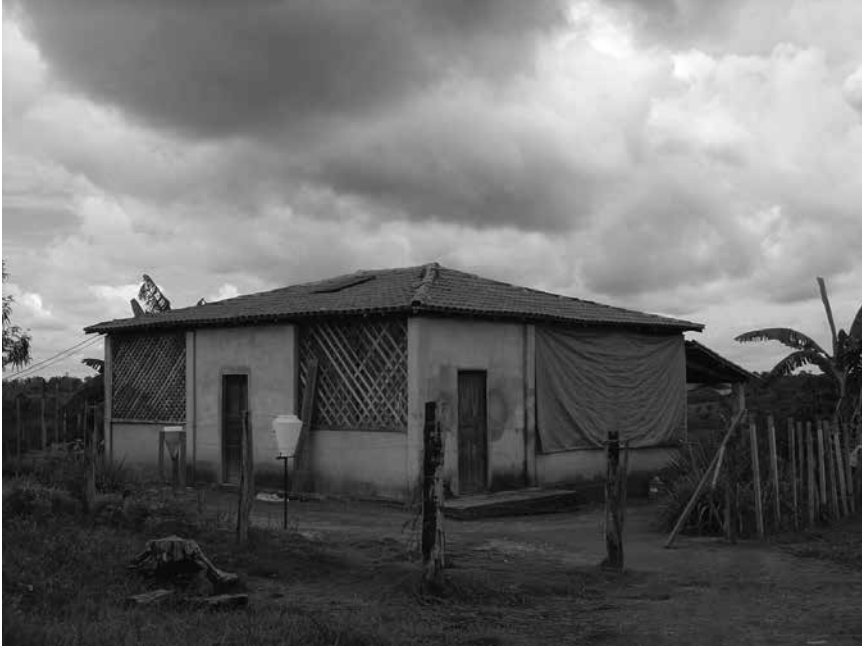
Foto 10 – Vista frontal da casa com pluviômetros e, no teto, placa de energia solar
