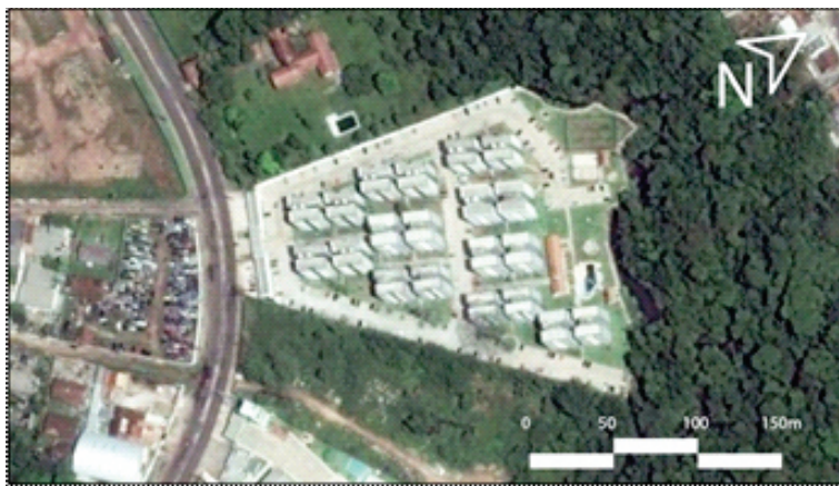
Figura 7: Condomínio Residencial Neo Colori, acessado pela Rodovia Mario Covas, com 28.000 m 2 , construído às margens de um dos braços do Rio Ariri.
